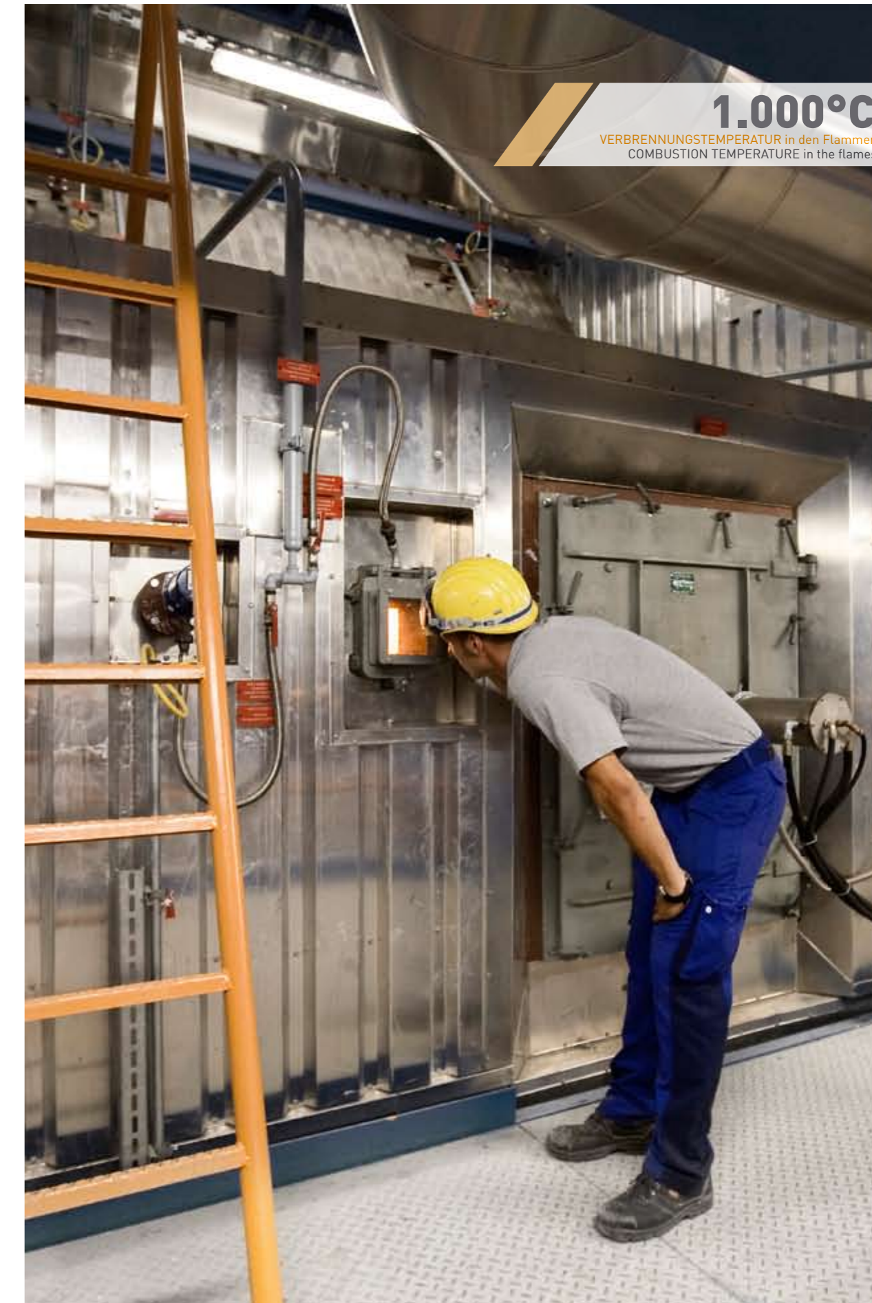
FEUERRAUM mit Vorschubrost COMBUSTION CHAMBER with forward-acting reciprocating grate
