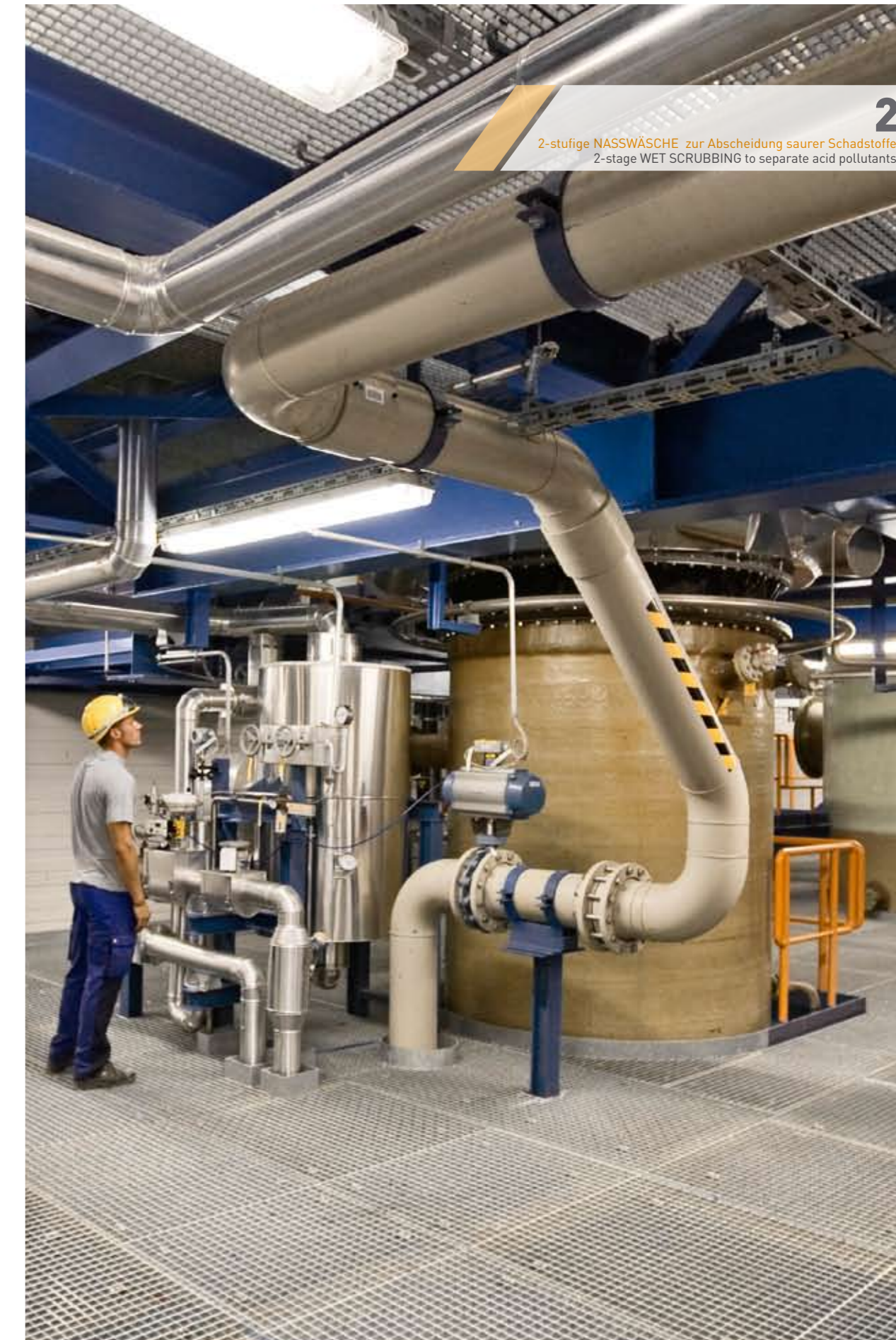
Eindüsung von Kalkmilch in den ZWEITEN WÄSCHER Injection of lime milk into the SECOND WET SCRUBBER
