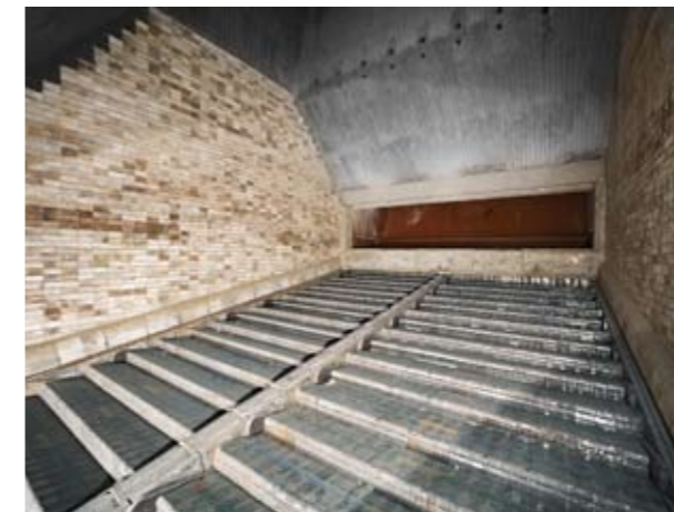
FEUERRAUM mit Vorschubrost COMBUSTION CHAMBER with forward-acting reciprocating grate
