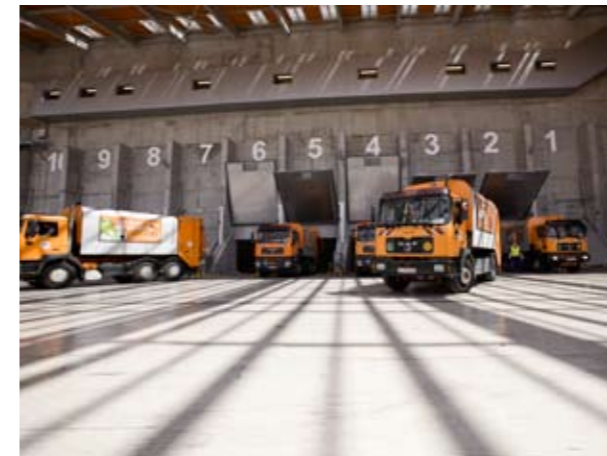
12 ABKIPPSTELLEN zur Entleerung 12 TILTING SPOTS for unloading
