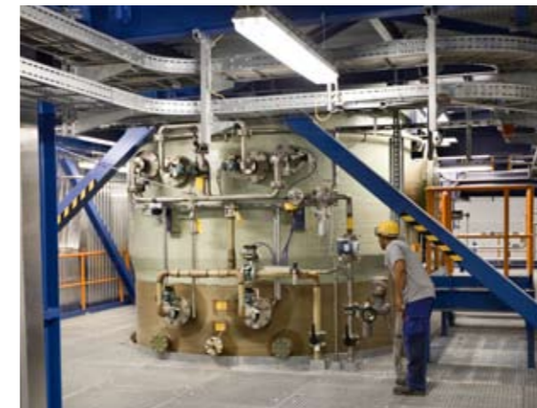
Eindüsung von Kalkmilch in den ZWEITEN WÄSCHER Injection of lime milk into the SECOND WET SCRUBBER
