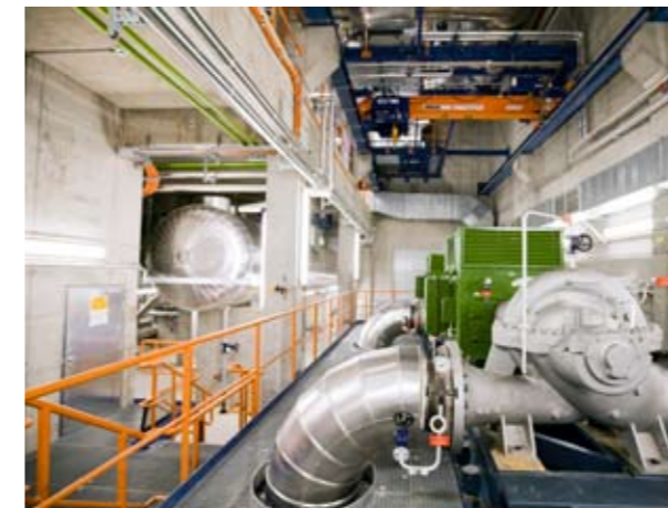
FERNWÄRMEPUMPEN DISTRICT HEATING PUMPS
